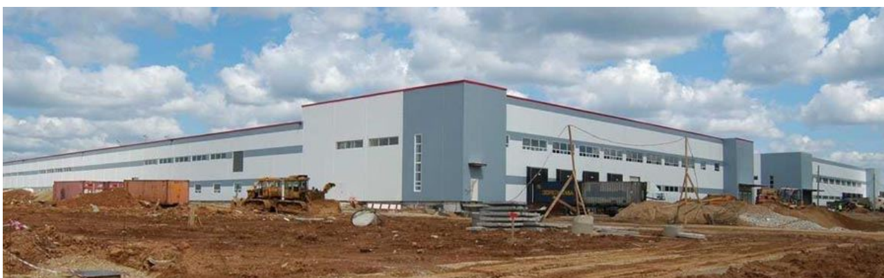
Рисунок 1. Строительство завода LG Electronics RUS.
